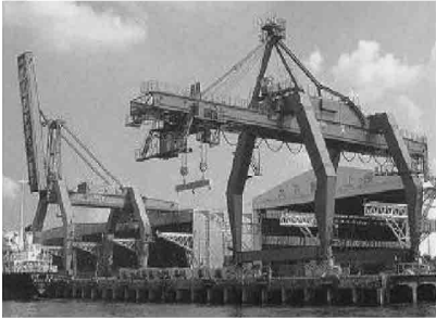
철판 하역(브릿지 형 크레인; BTC)
